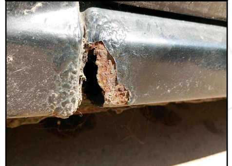
CAIXAS DE AR - SOLEIRA ESQUERDA
