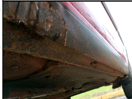
CAIXA DE AR/ SOLEIRA ESQUERDA
