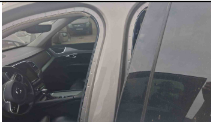
Foto Estrutura Coluna Central Esquerda
