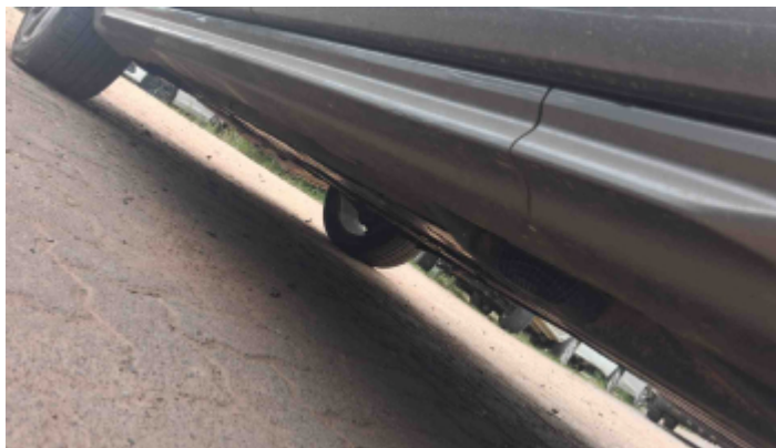
Foto Estrutura Assoalho
