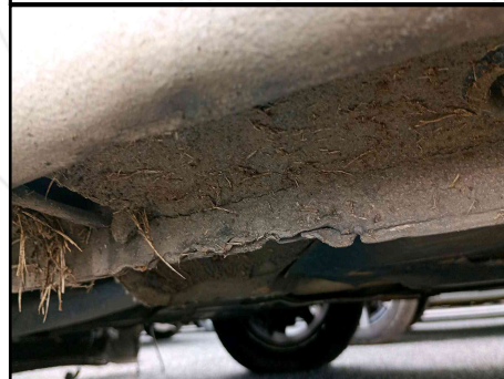
CAIXA DE AR/ SOLEIRA ESQUERDA
