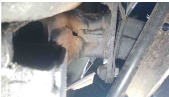
Foto Estrutura Longarina Direita
