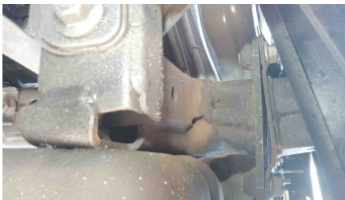
Foto Estrutura Longarina Esquerda
