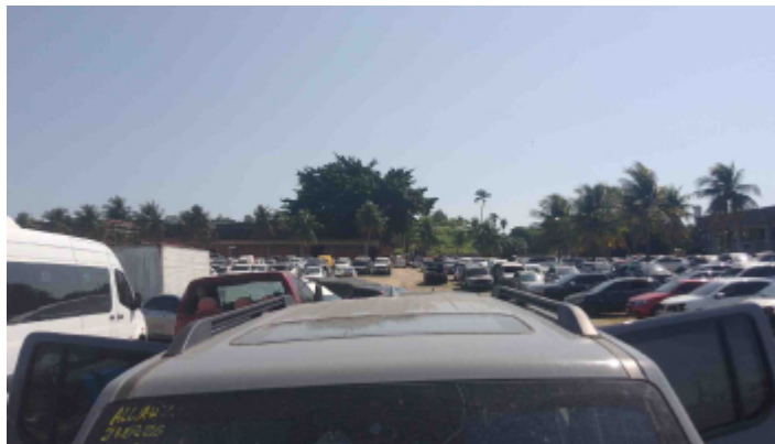
Foto Estrutura Teto
