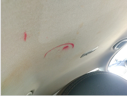
REVESTIMENTO DO TETO
