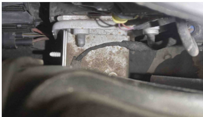
Foto Estrutura Longarina Direita
