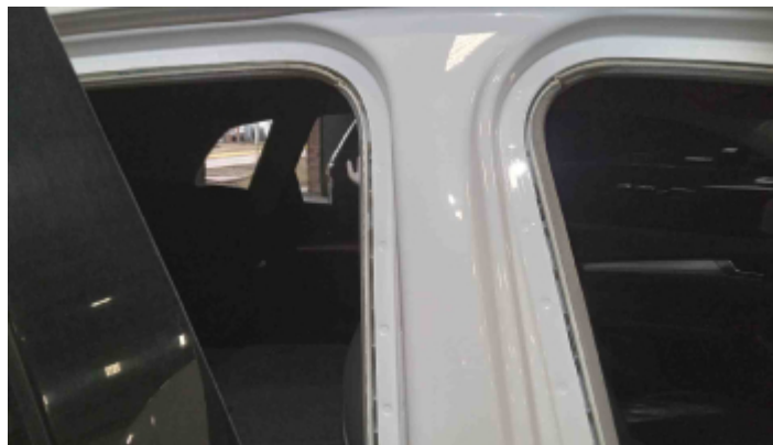
Foto Estrutura Coluna Central Direita
