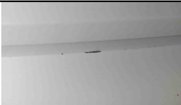
Foto Avaria Pára-Choque Traseiro
