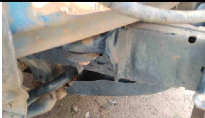
Foto Estrutura Torre do Amortecedor Direito
