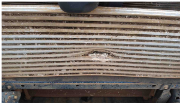
Foto Avaria Motor
