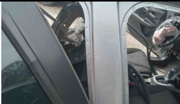
Foto Estrutura Coluna Central Direita
