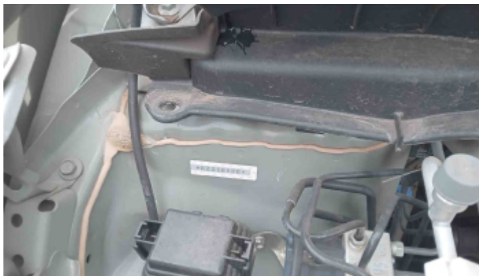
Foto Estrutura Torre do Amortecedor Esquerdo
