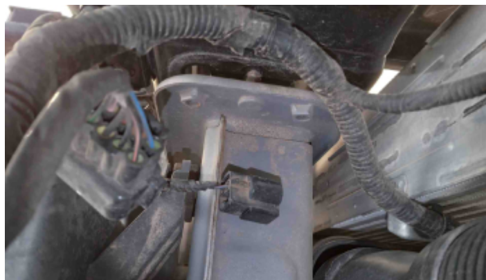
Foto Estrutura Longarina Esquerda
