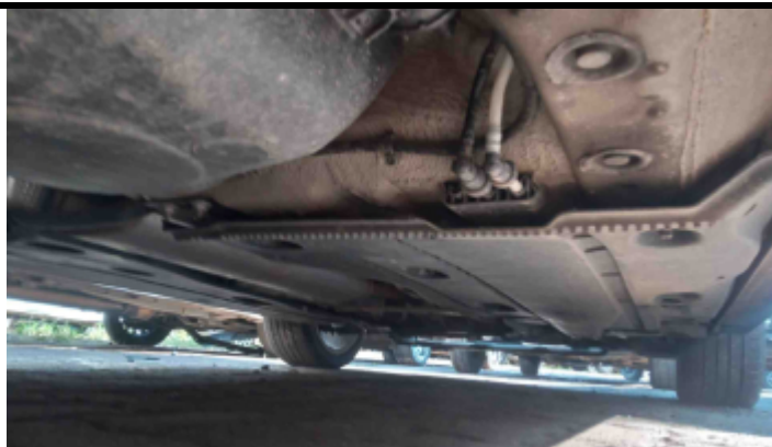
Foto Estrutura Assoalho
