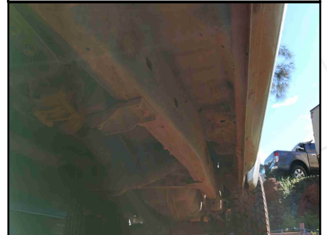
CAIXAS DE AR - SOLEIRA ESQUERDA
