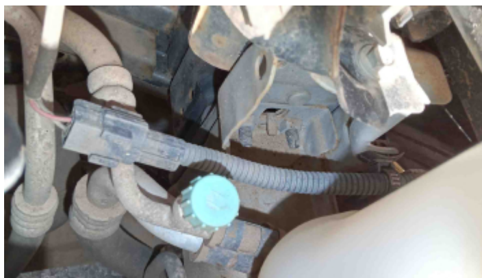
Foto Estrutura Longarina Direita
