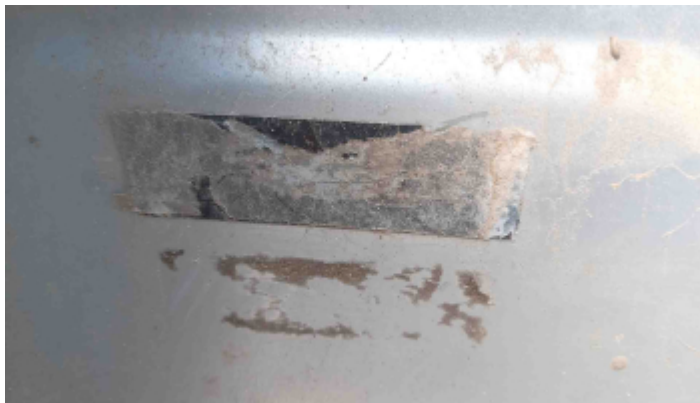
Foto da etiqueta ETA (batente da porta)
