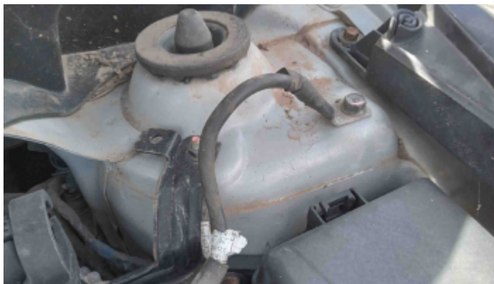
Foto Estrutura Torre do Amortecedor Esquerdo
