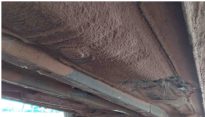
Foto Estrutura Assoalho
