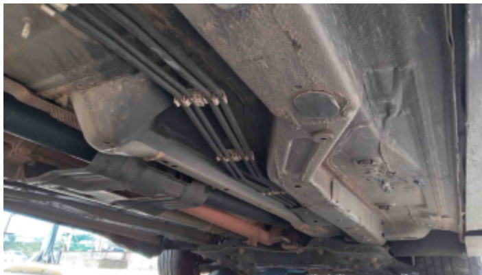
Foto Estrutura Assoalho
