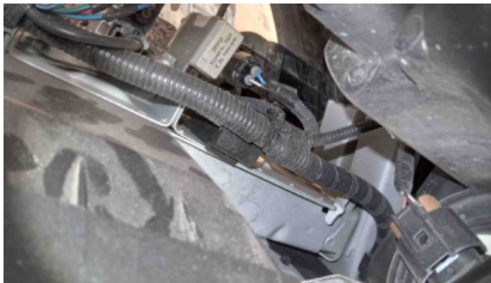
Foto Estrutura Longarina Esquerda
