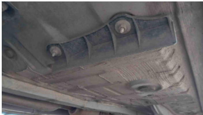
Foto Estrutura Assoalho
