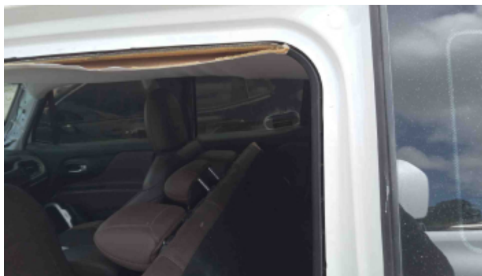
Foto Estrutura Coluna Traseira Esquerda
