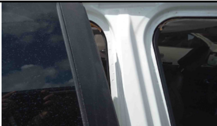
Foto Estrutura Coluna Central Direita
