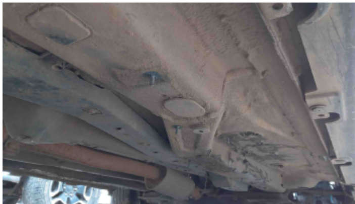
Foto Estrutura Assoalho
