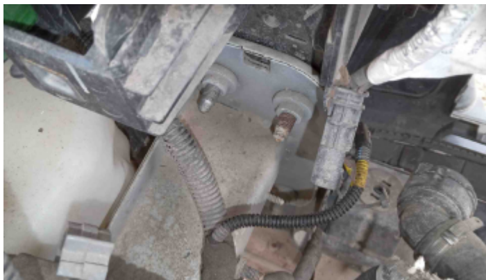
Foto Estrutura Longarina Esquerda
