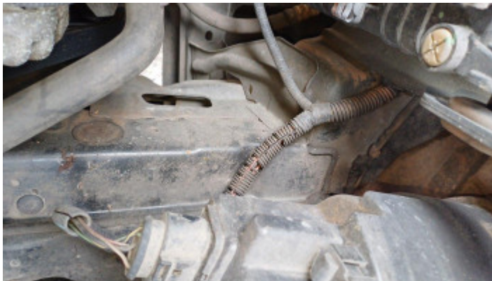
Estrutura Longarina Direita
