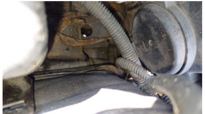
Estrutura Longarina Esquerda
