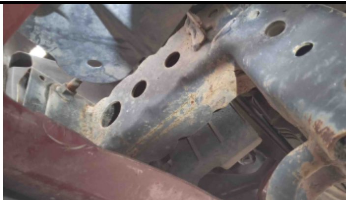
Foto Estrutura Longarina Esquerda
