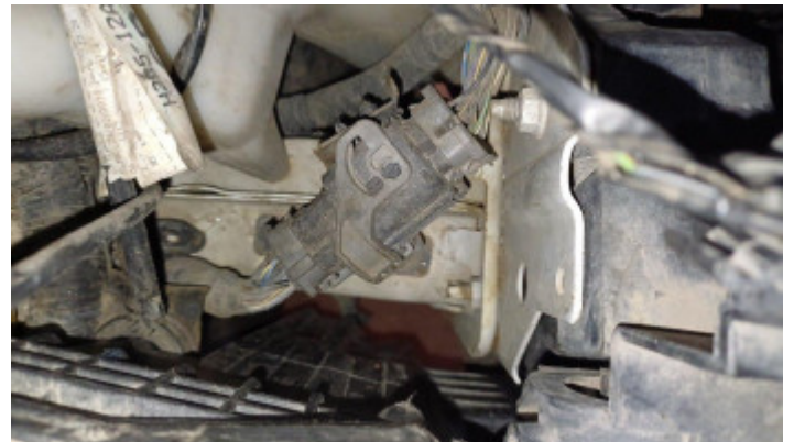
Estrutura Longarina Esquerda
