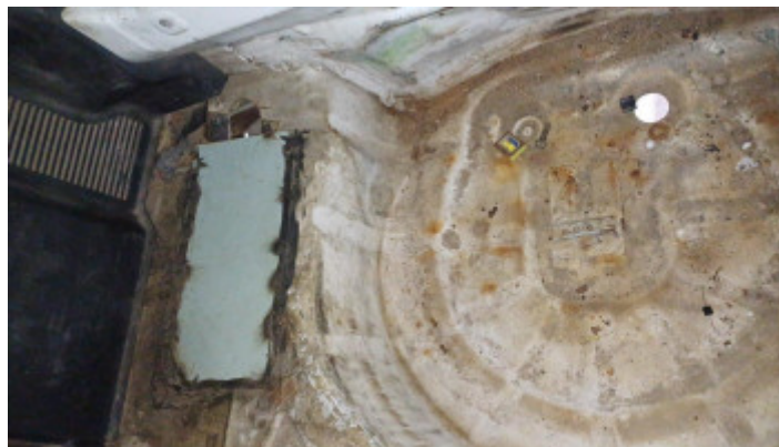
Avaria Caixa de Estepe
