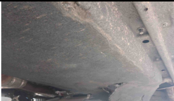
Foto Estrutura Assoalho
