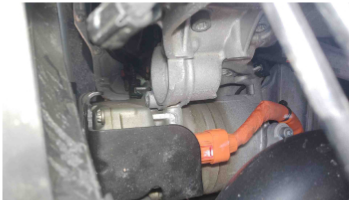
Foto Ar Condicionado
