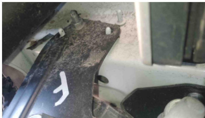
Foto Estrutura Longarina Esquerda
