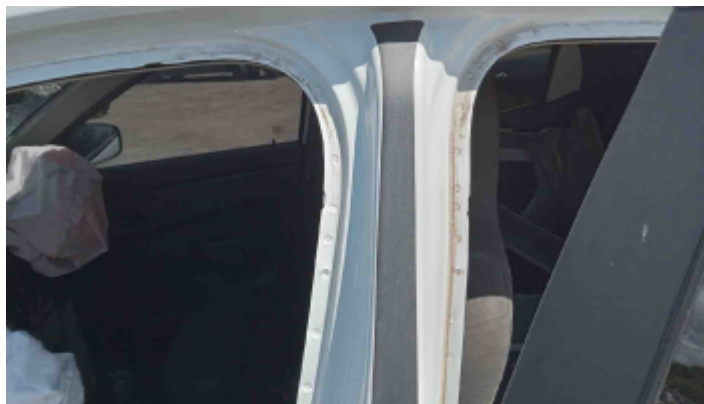
Foto Estrutura Coluna Central Esquerda
