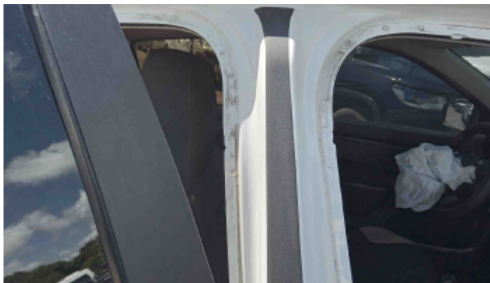
Foto Estrutura Coluna Central Direita
