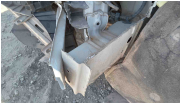
Foto Estrutura Longarina Esquerda
