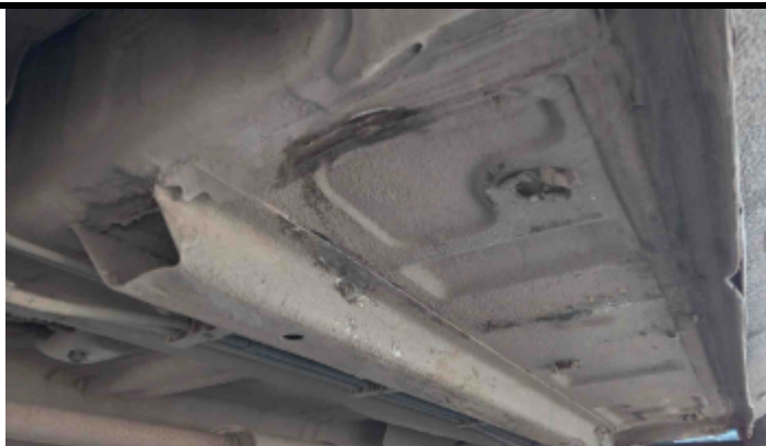
Foto Estrutura Assolho
