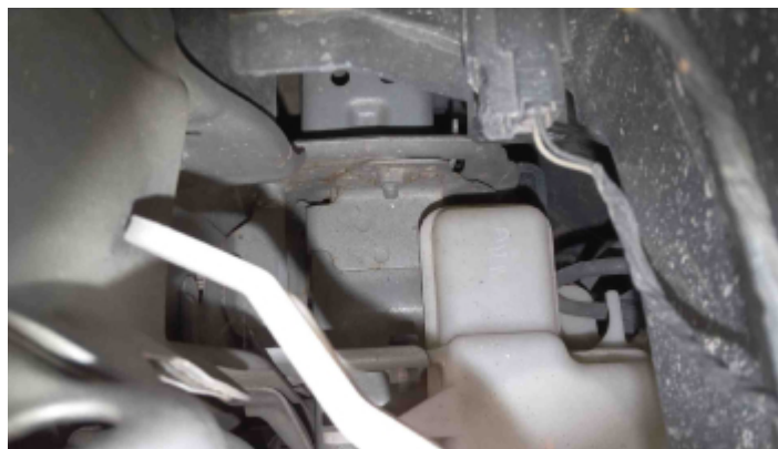
Foto Estrutura Longarina Direita
