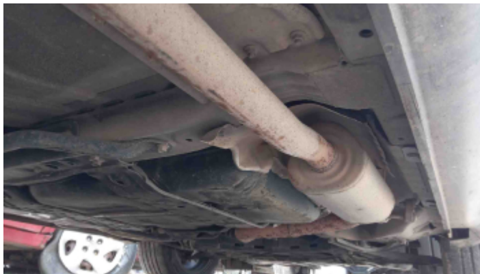
Foto Estrutura Assoalho
