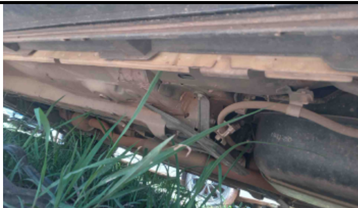
Foto Estrutura Assoalho
