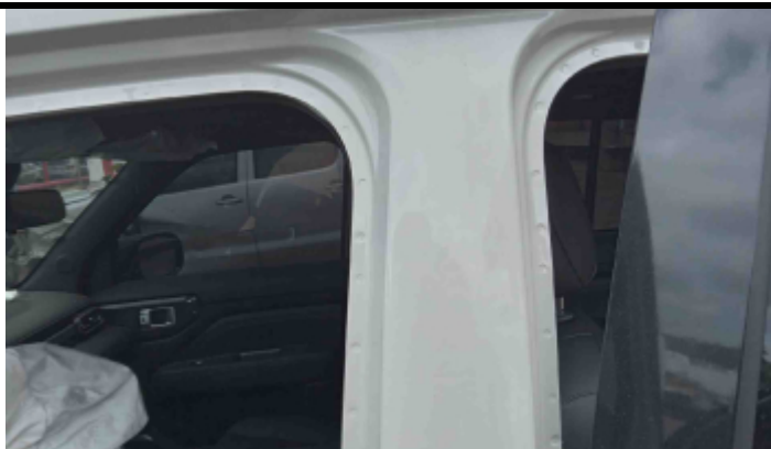
Foto Estrutura Coluna Central Esquerda
