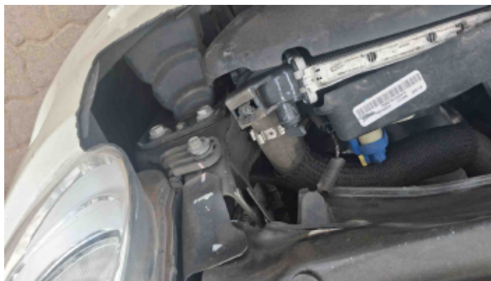
Foto Estrutura Longarina Esquerda
