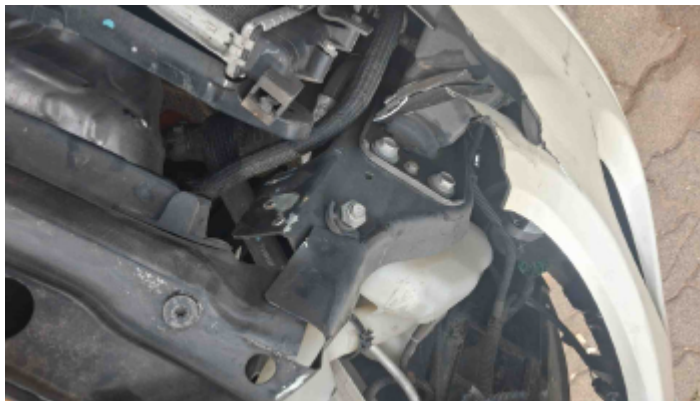
Foto Estrutura Longarina Direita
