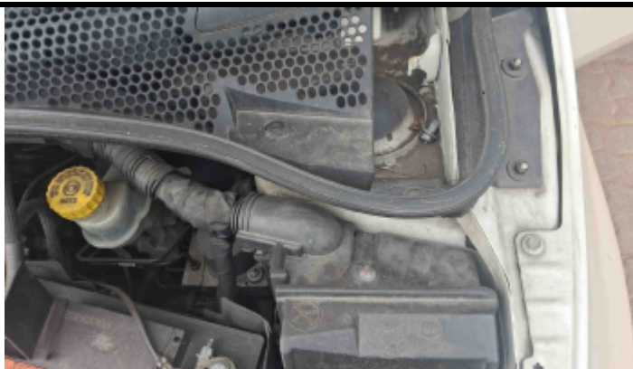
Foto Estrutura Torre do Amortecedor Esquerdo
