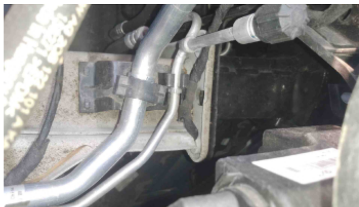
Foto Estrutura Longarina Direita
