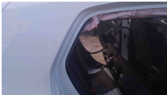
Foto Estrutura Coluna Traseira Direita
