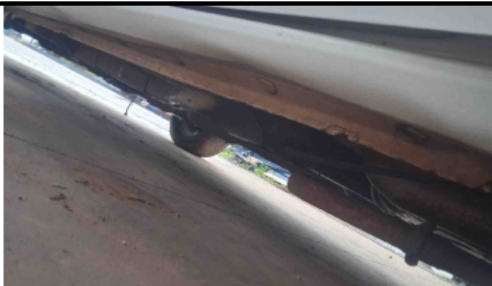
Foto Estrutura Assoalho
