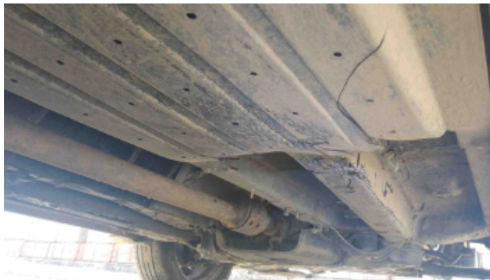
Foto Estrutura Assoalho
