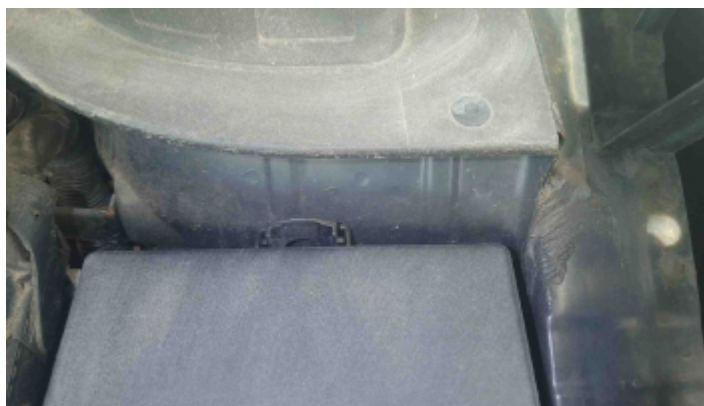
Foto Estrutura Torre do Amortecedor Esquerdo
