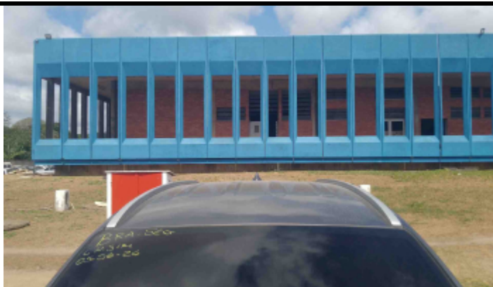
Foto Estrutura Teto
