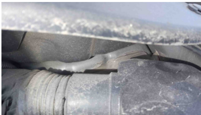
Foto Estrutura Torre do Amortecedor Esquerdo
