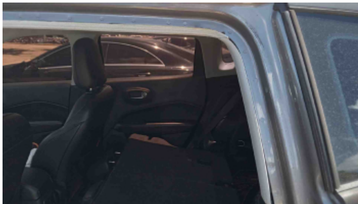
Foto Estrutura Coluna Traseira Esquerda
