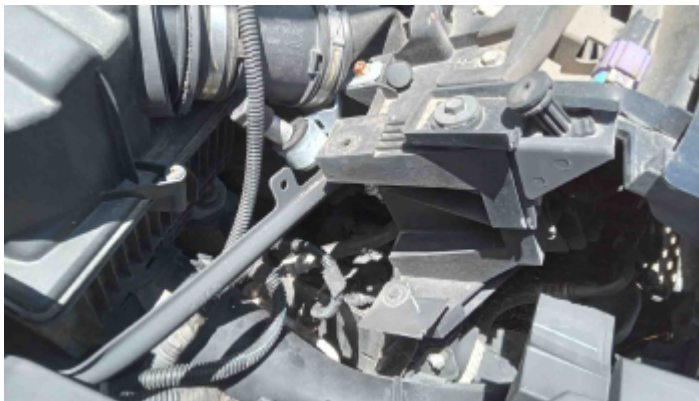
Foto Ar Condicionado
