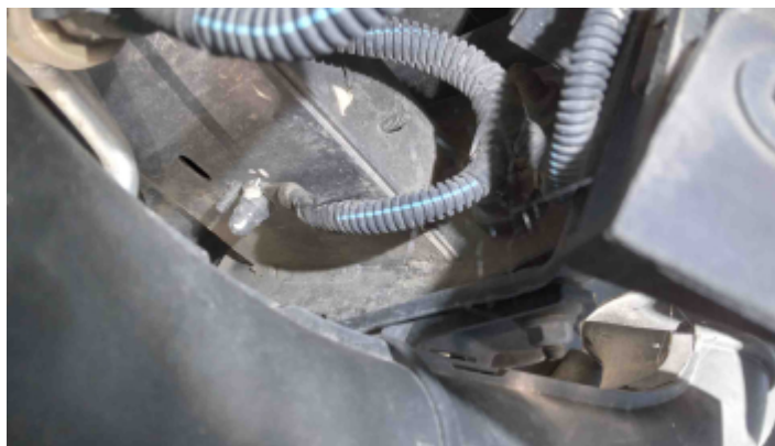
Foto Estrutura Longarina Direita
