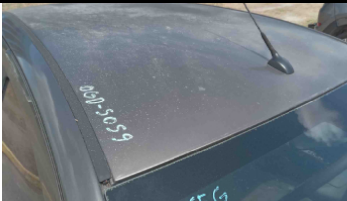
Foto Estrutura Teto
