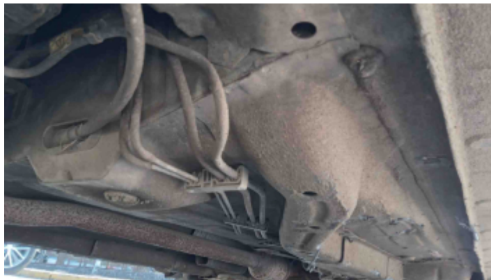
Foto Estrutura Assoalho
