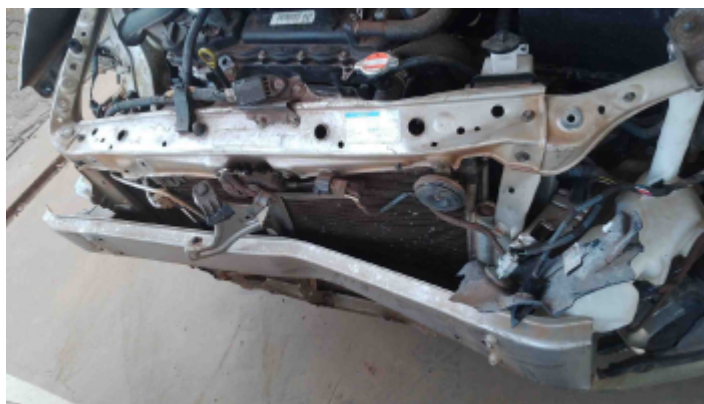
Foto Avaria Painel/Saia Dianteiro
