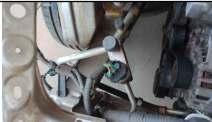
Foto Ar Condicionado
