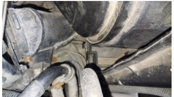
Estrutura Longarina Esquerda
