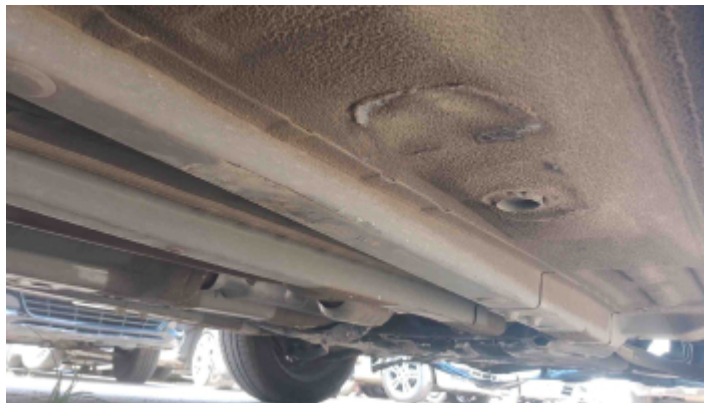
Foto Estrutura Assoalho
