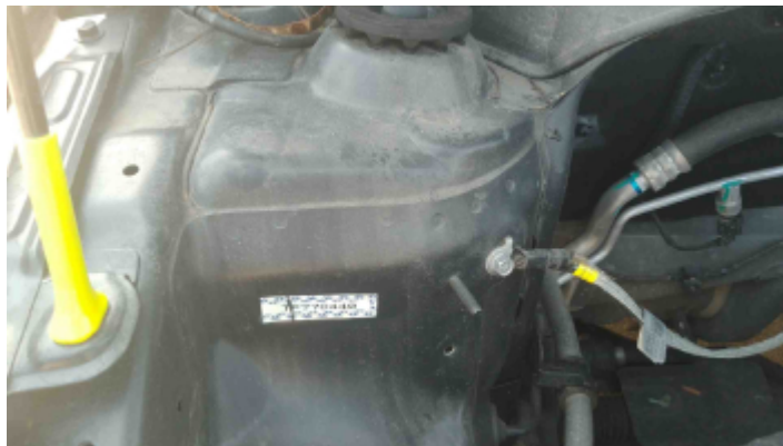
Foto Estrutura Torre do Amortecedor Direito
