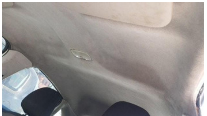
Revestimento do teto
