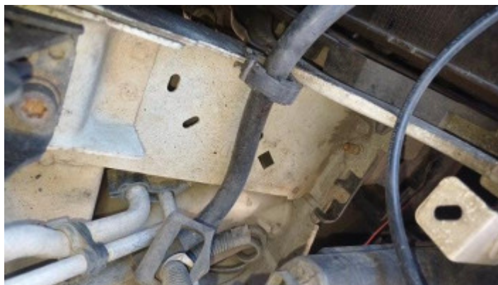
Estrutura Longarina Direita
