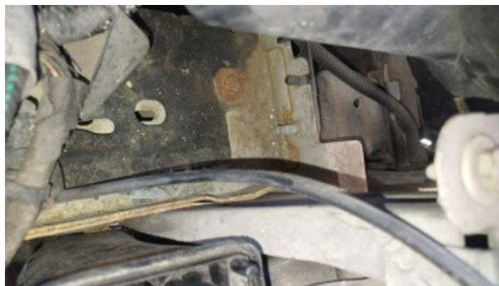
Estrutura Longarina Esquerda
