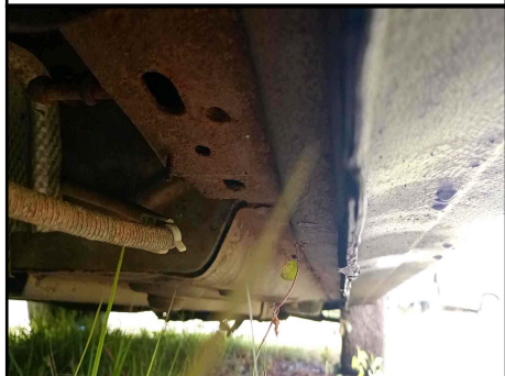
CAIXAS DE AR - SOLEIRA DIREITA
