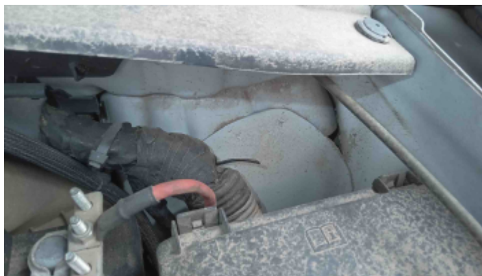
Foto Estrutura Torre do Amortecedor Esquerdo
