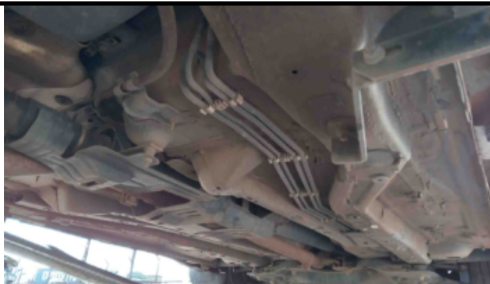
Foto Estrutura Assoalho
