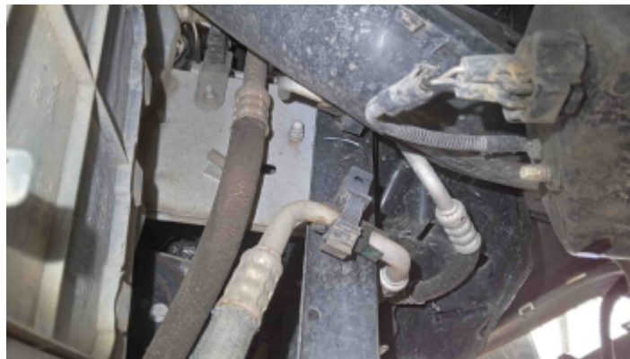
Foto Estrutura Longarina Direita
