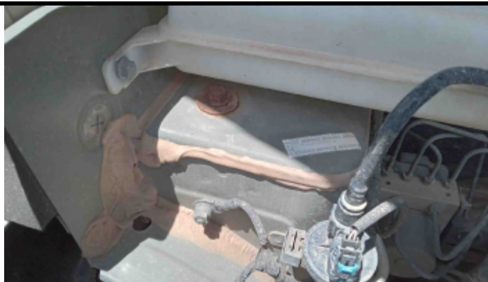
Foto Estrutura Torre do Amortecedor Direito
