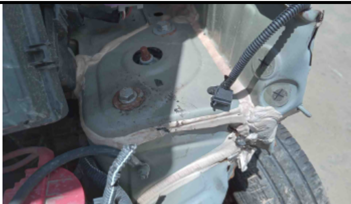
Foto Estrutura Torre do Amortecedor Esquerdo
