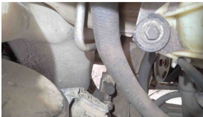
Foto Ar Condicionado
