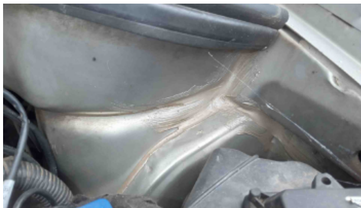
Foto Estrutura Torre do Amortecedor Esquerdo
