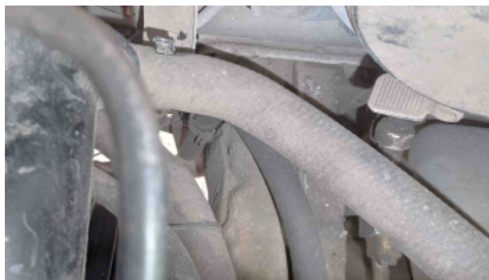
Foto Estrutura Longarina Direita
