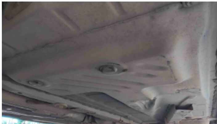
Foto Estrutura Assoalho
