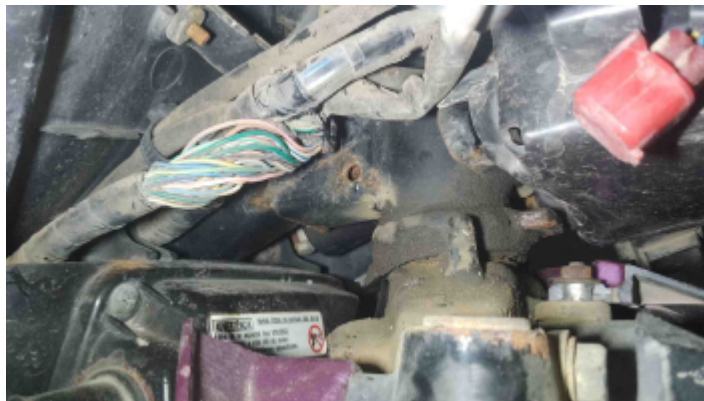
Foto Estrutura Quadro
