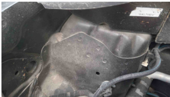
Foto Estrutura Torre do Amortecedor Direito
