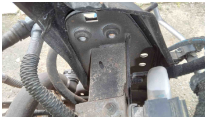
Foto Estrutura Longarina Direita
