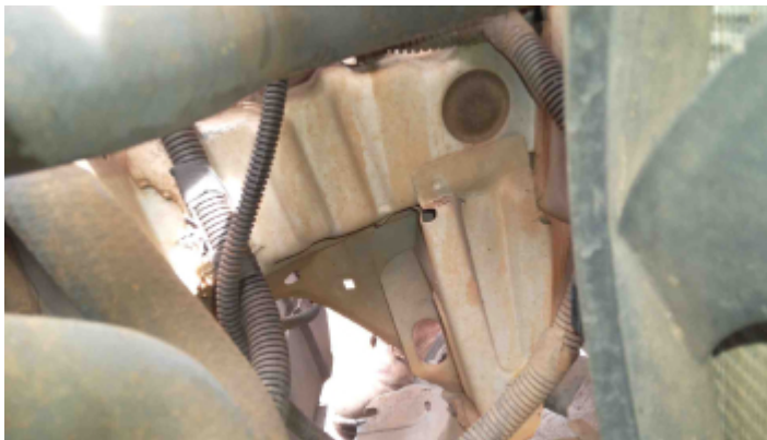
Foto Estrutura Longarina Esquerda
