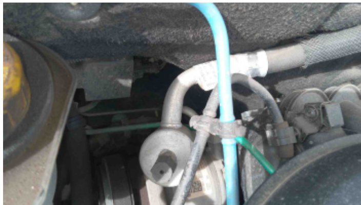
Foto Ar Condicionado
