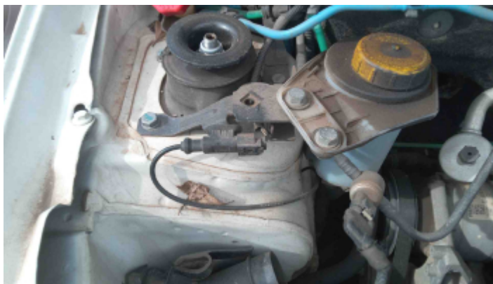
Foto Estrutura Torre do Amortecedor Direito
