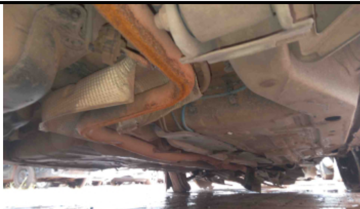
Foto Estrutura Assoalho
