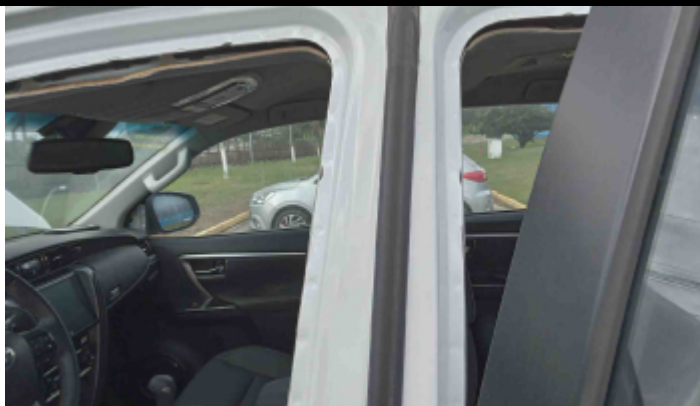
Foto Estrutura Coluna Central Esquerda
