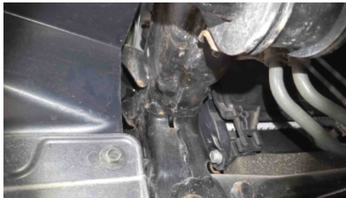
Foto Estrutura Longarina Esquerda
