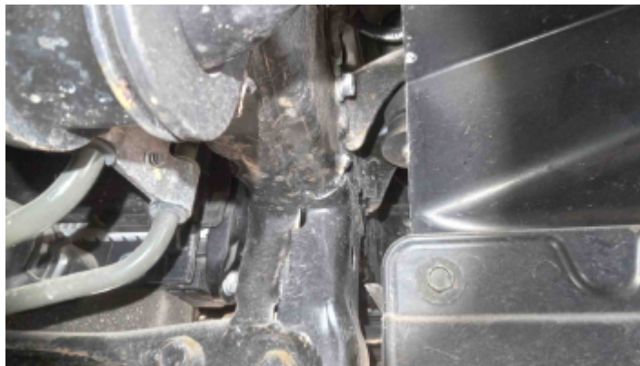
Foto Estrutura Longarina Direita
