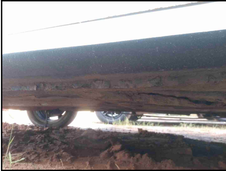
CAIXA DE AR/ SOLEIRA ESQUERDA
