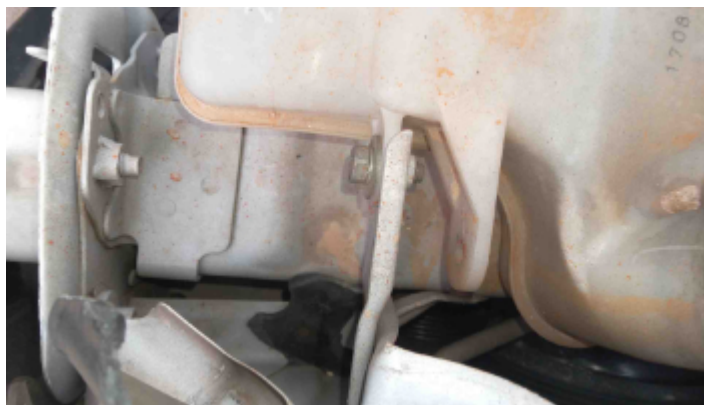
Foto Estrutura Longarina Direita
