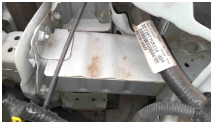
Foto Estrutura Longarina Esquerda
