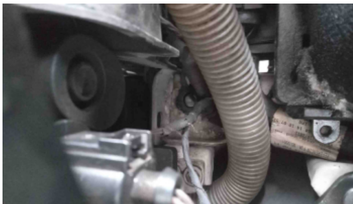
Foto Estrutura Longarina Esquerda
