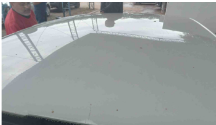
Foto Avaria Teto
