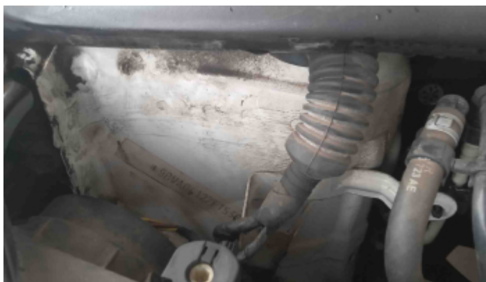
Foto Estrutura Torre do Amortecedor Direito
