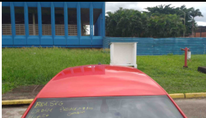
Foto Estrutura Teto
