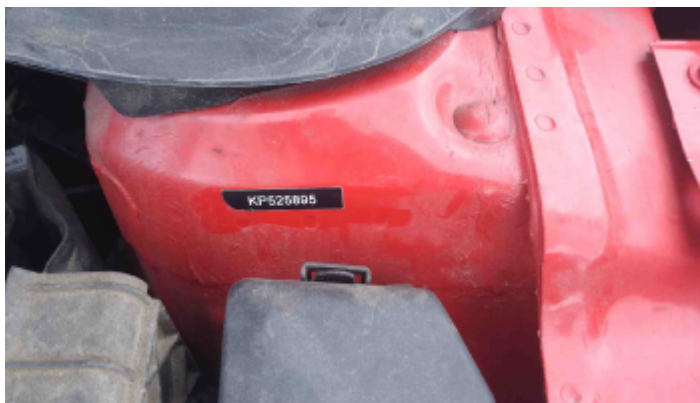
Foto Estrutura Torre do Amortecedor Esquerdo
