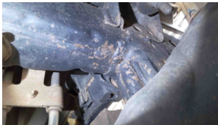
Foto Estrutura Longarina Direita
