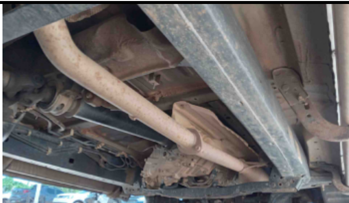
Foto Estrutura Assoalho
