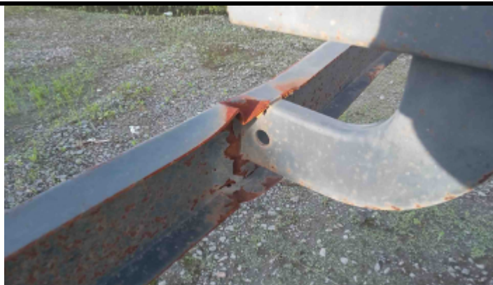
Foto Avaria Pára-Choque Traseiro
