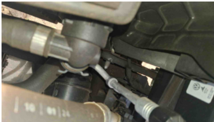
Foto Estrutura Longarina Direita
