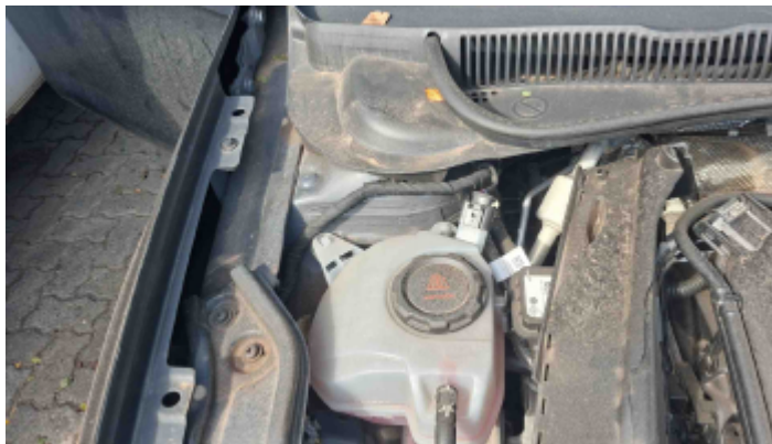
Foto Estrutura Torre do Amortecedor Direito
